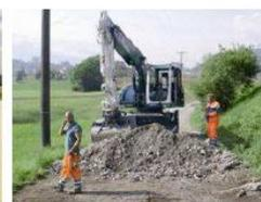
Démolition d'une piste, en reculant et en circulant sur la piste
