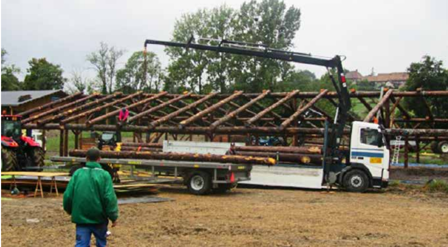
Démontage d'une structure en bois qui allait servir pour le giron de Vers-chez-les-Blanc.
